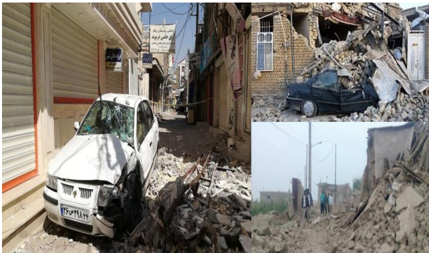
تصویر ۲: خسارات وارده به ساختمان‌ها
