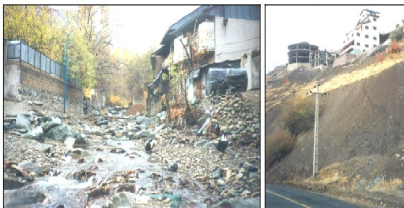
شکل ۸: سمت راست دامنه برای ویلا سازی و ساخت و سازهای بعضاً بلندمرتبه تسطیح شده و این موجب افزایش وزن دامنه می‌شود و از طرفی ایجاد ترانشه‌های عمیق به منظور راه‌سازی و تخلیه زیربنای دامنه‌ها مخاطره وقوع لغزش‌ها را تشدید می‌کند. سمت چپ نیز افزایش قیمت زمین‌ها موجب تصرف و تجاوز به حریم سیل‌گیر رودخانه‌ها در حوضه آهار شده و لغزش‌های مجاور رودخانه و مخاطره سیل پیامدهای آن می‌باشد. مأخذ: نویسندگان
