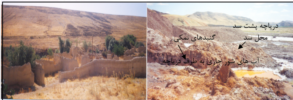
شکل ۹: جریان آب‌های شور به دریاچه پشت سد و سایش گنبد های نمکی و روستاهای ترک شده و مزارع متروک و دامنه‌های تحت فرسایش در روستاهای واقع در بالا دست سد سهند
