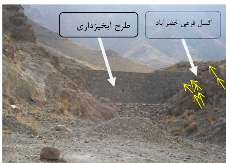
شکل ۹: نمای طرح آبخیزداری در نزدیکی گسل فرعی خضر آباد
